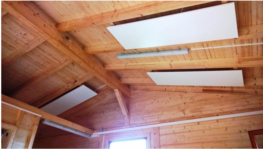
Deckenmontage von mehreren Infrarotheizungen in Standard weiß in einem Kindergarten
